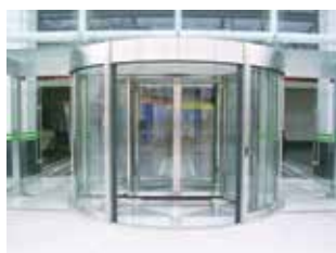
Controlli automatici porte
